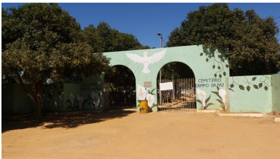
Figura 20: Fachada e entrada do cemitério
